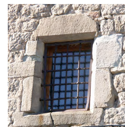
Exemple de barreaudage de défense, dont les plus simples, pour les petites ouvertures, sont réalisés avec des barreaux isolés de 25 x 25 mm, scellés dans les tableaux, appuis ou linteaux
