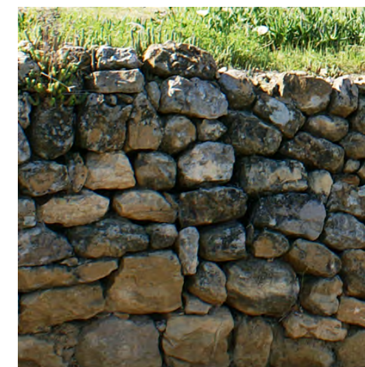
Muret de soutènement des terrasses en pierres de calcaire et de grès montés à sec
