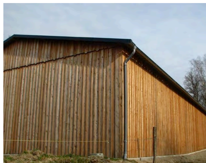
utilisation de bardage bois vertical pour bâtiment d'élevage
