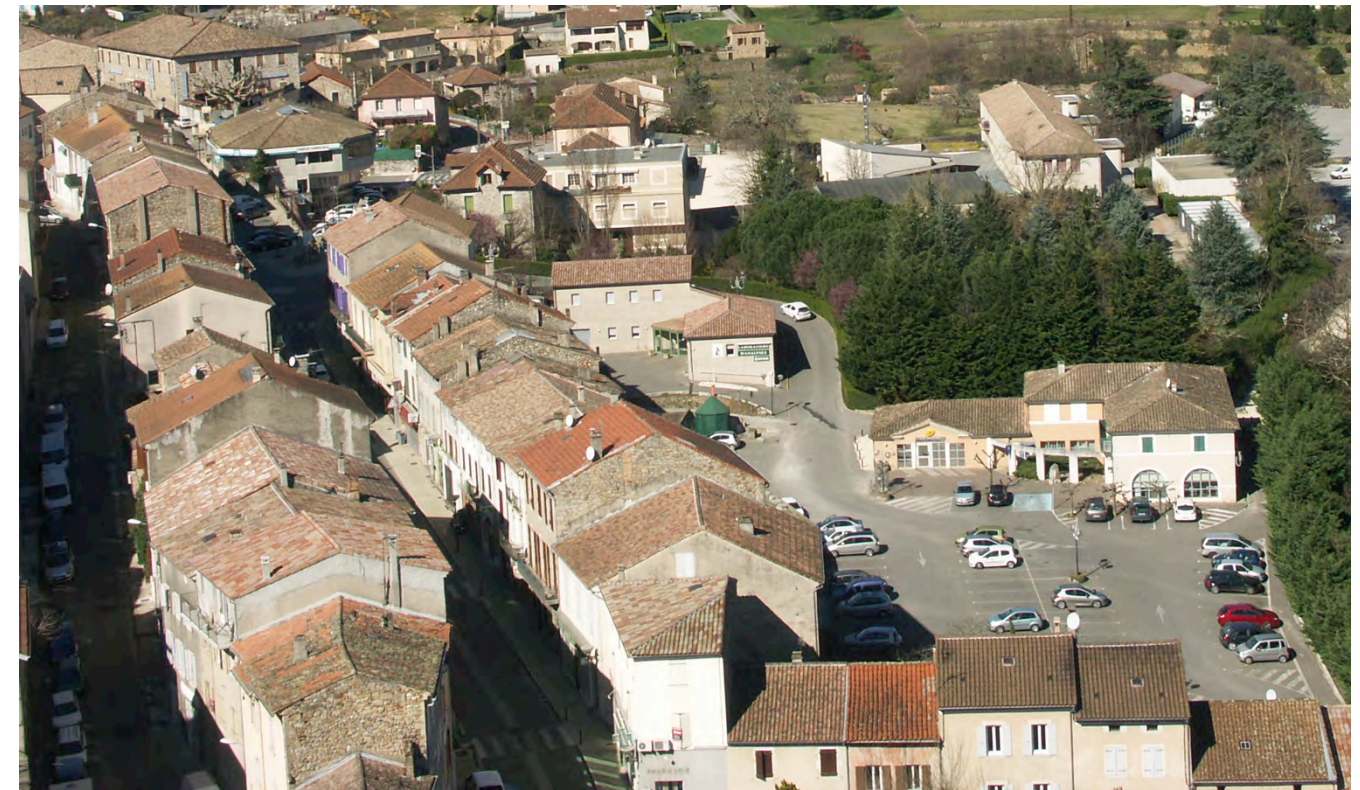
La partie ouest du secteur S2 composée de bâtiments édifiés à l'alignement des voies formant une armature urbaine, les espaces à l'arrière en jardins ou terrains cultivés ont été urbanisés à partir du milieu du XXe siècle.
