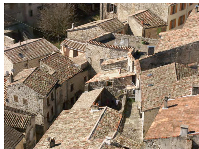
Les toits du quartier du Barry mettent en évidence la prédominance de la tuile canal
