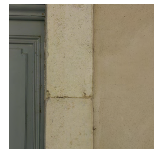
Enduit taloché venant en butée contre les pierres d'encadrement d'une porte
