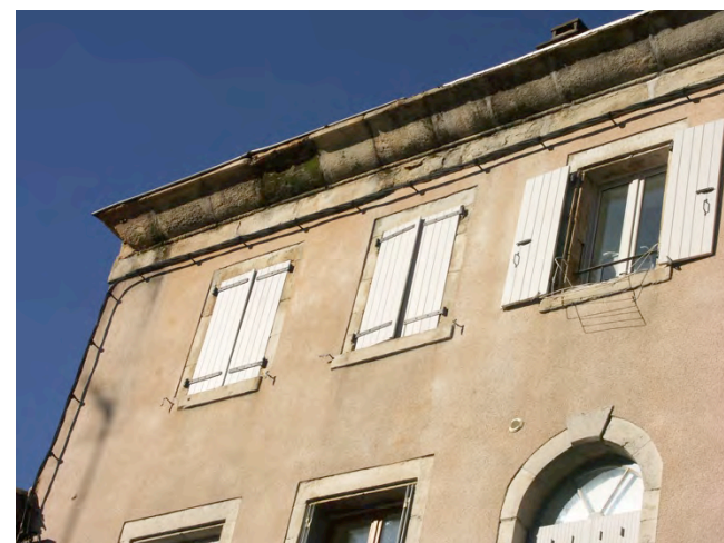
Rare exemple à Joyeuse de corniche en pierre remplaçant une génoise.
