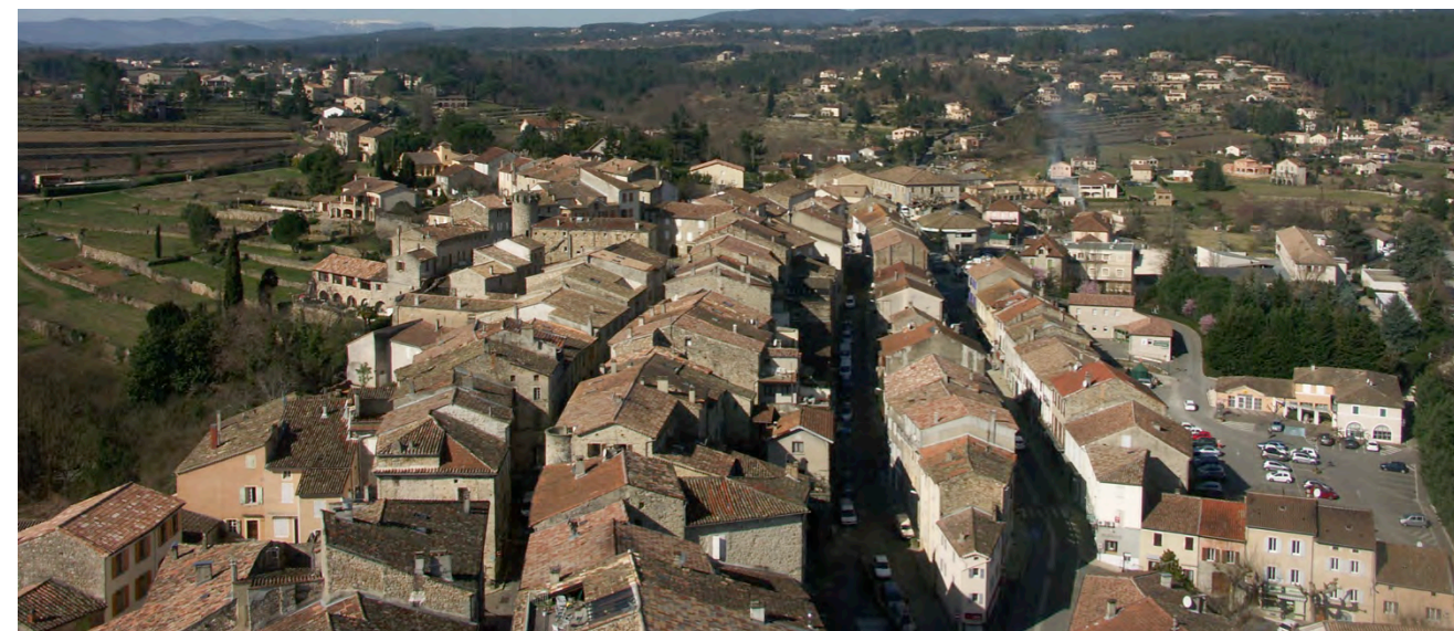
Point de vue particulier depuis le clocher sur les toitures du centre ancien et du faubourg XIXe en relation immédiate
