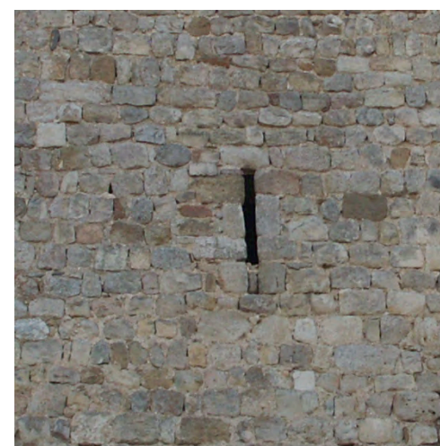
Exemple de maçonnerie de moellons taillés destinés à rester apparents
