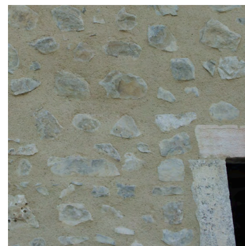
Jointoiment à joints bien garnis sur une maçonnerie en moellons tout venant
