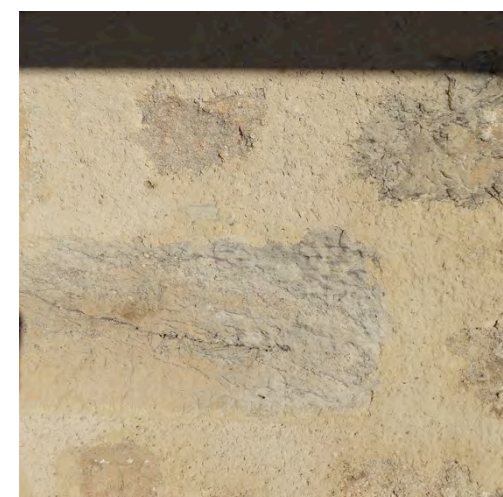
Maçonnerie de moellons taillés ayant reçue un jointoiment à fleur de la pierre
