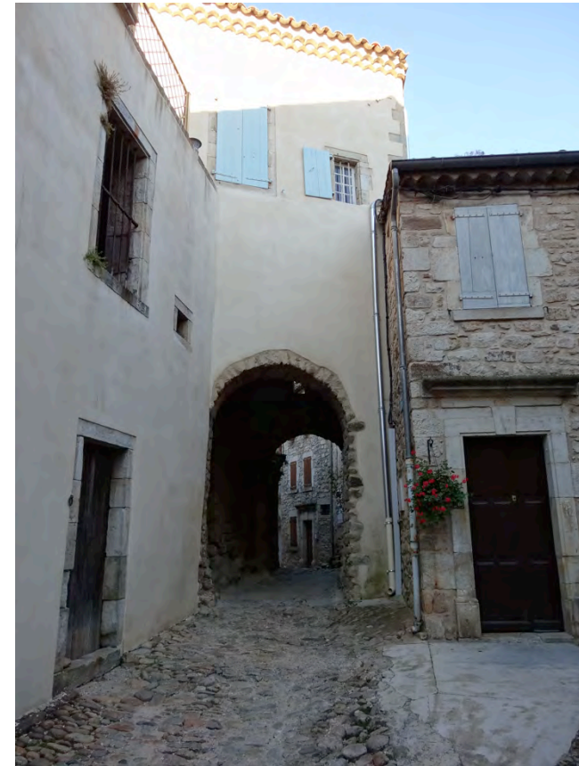
Passage sous porche rue de Gaudinelle
